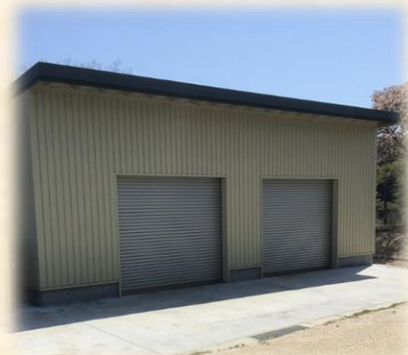
圃場わきに完成した農機具倉庫
